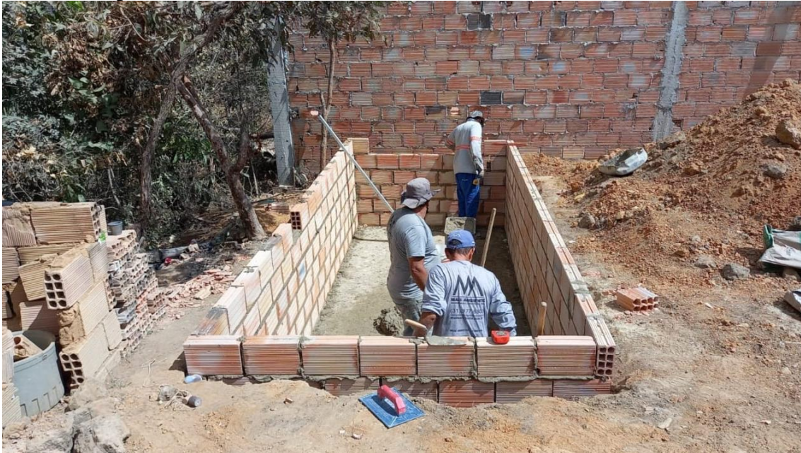
Foto 2 - Etapa construtiva da Alvenaria (TEVAP).
