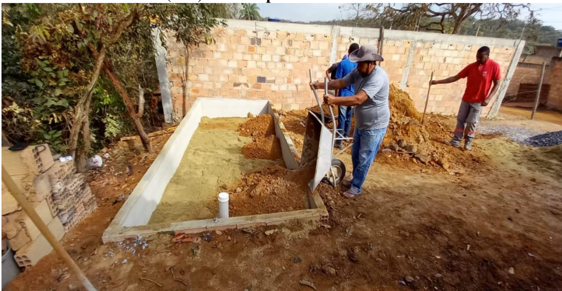
Foto 8 - Última camada (solo) sendo depositada na TEVAP.
