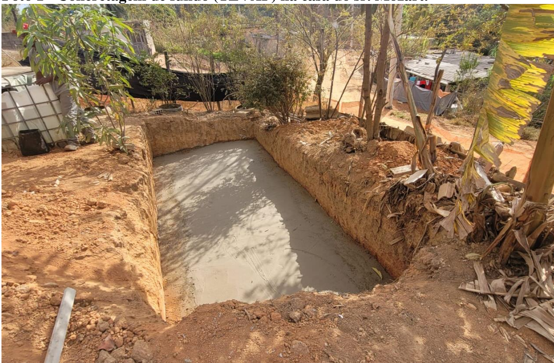
Foto 1 - Concretagem de fundo (TEVAP) na casa do sr. Mozart.
