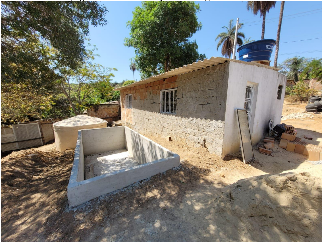
Foto 22 - TEVAP construída ao fundo da cozinha comunitária, com alvenaria e reboco concluídos, aguardando a oficina para montagem.
