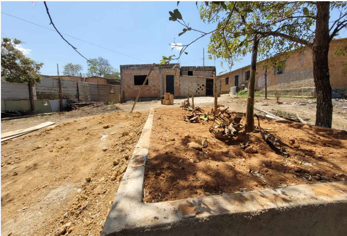
Foto 16 - TEVAP Concluída na casa da dona Eliana
