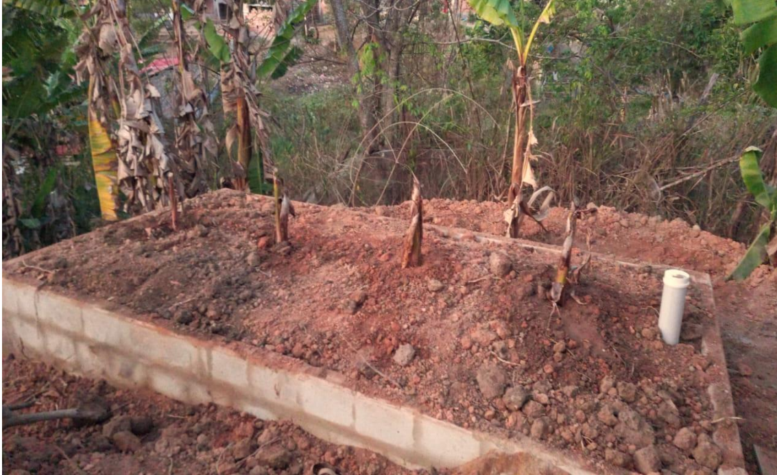
Foto 21 - TEVAP Concluída na casa do sra. Madalena.
