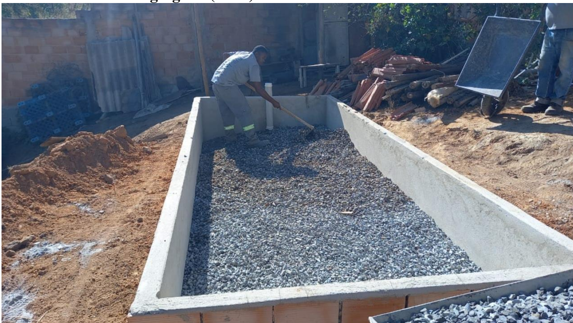
Foto 6 - Camada de agregado (brita) sendo finalizada na TEVAP.
