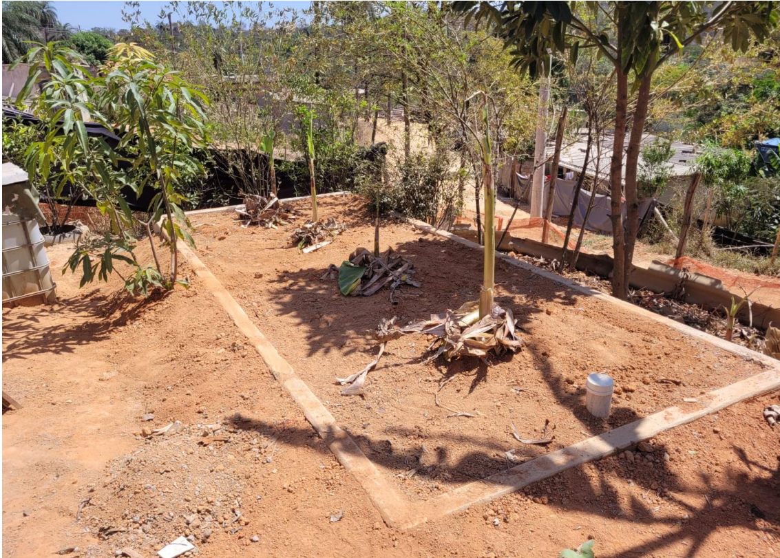
Foto 19 - TEVAP Concluída na casa do sr. Mozart José.
