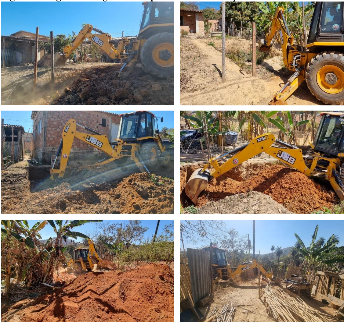
Figura 3 - Registros fotográficos de processos de escavação das TEVAPS
