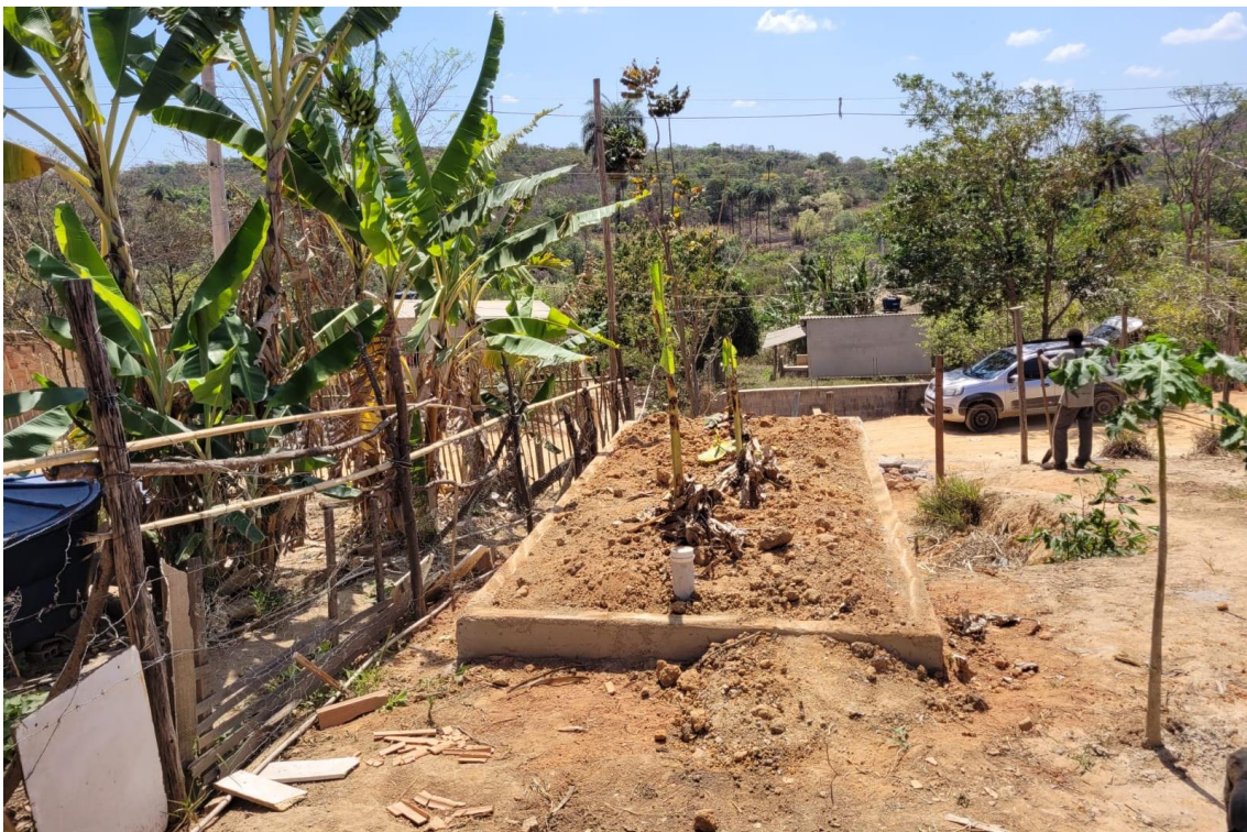
Foto 20 - TEVAP Concluída na casa do sr. Mozart José.
