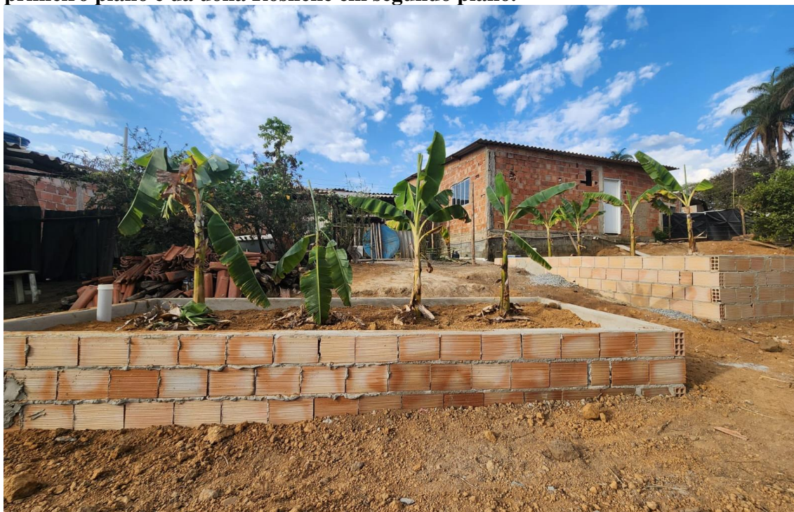
Foto 11 - Plantio de bananeiras finalizando a TEVAP da casa do “Maranhão” em primeiro plano e da dona Rosilene em segundo plano.
