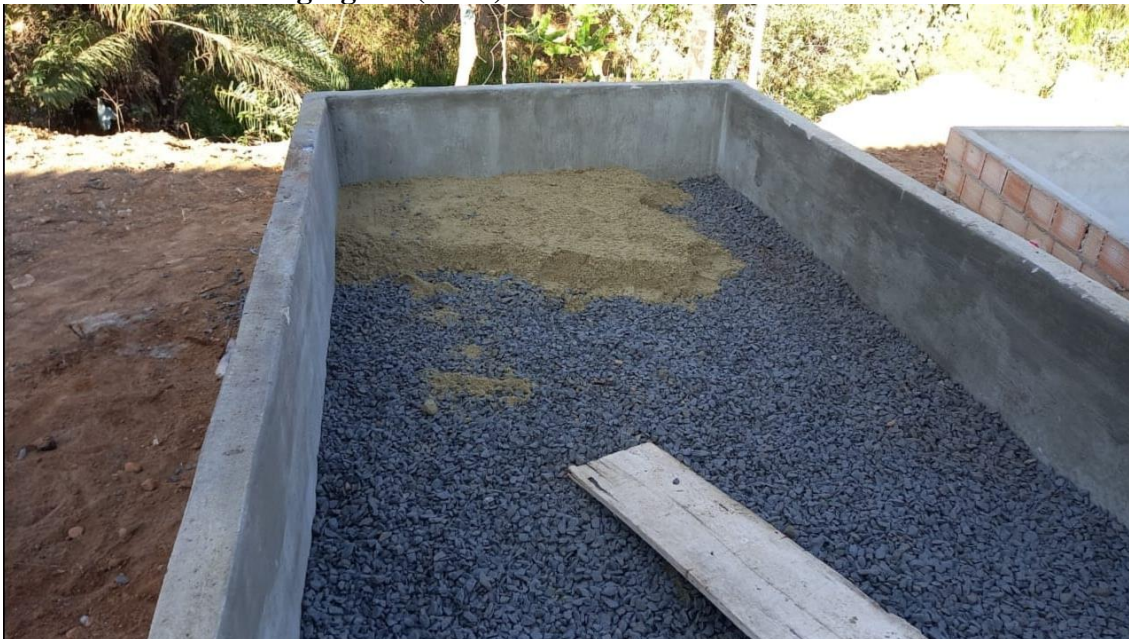
Foto 7 - Camada de agregado (areia) sendo colocada na TEVAP
