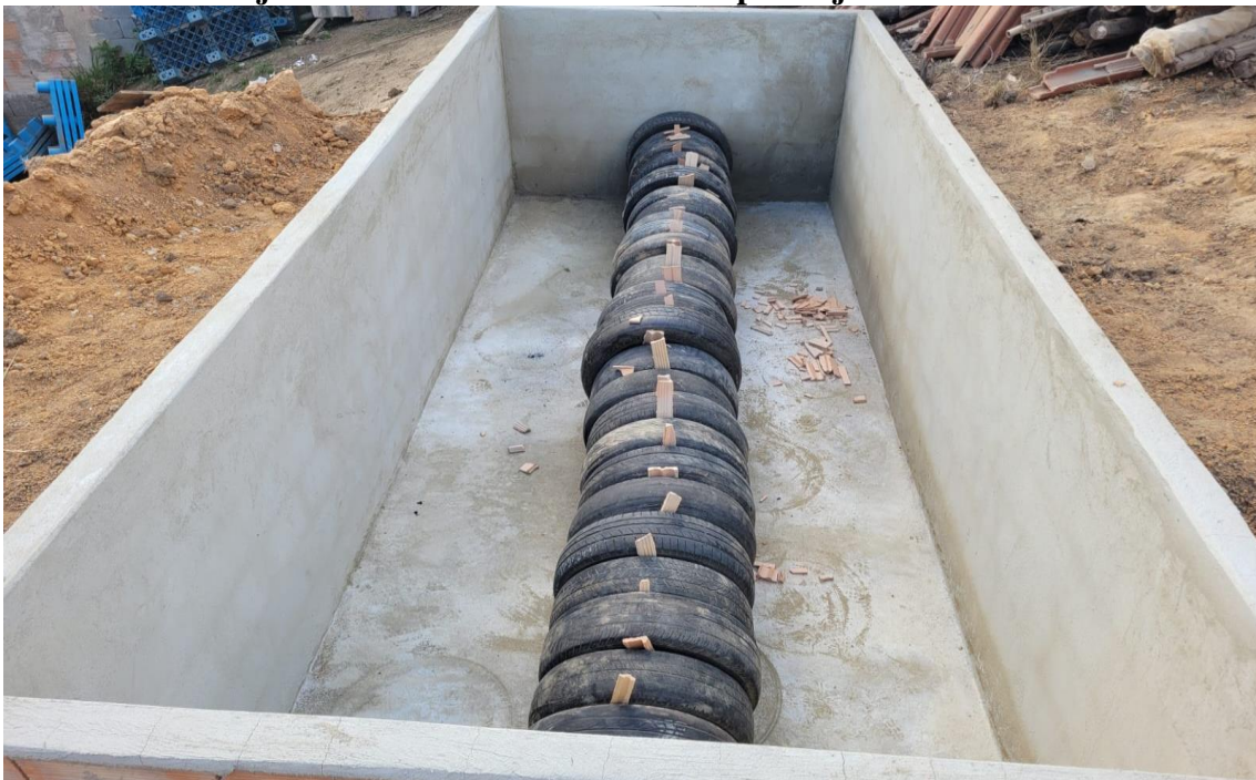
Foto 4 - TEVAP já rebocada e com a câmara de pneus já instalada.
